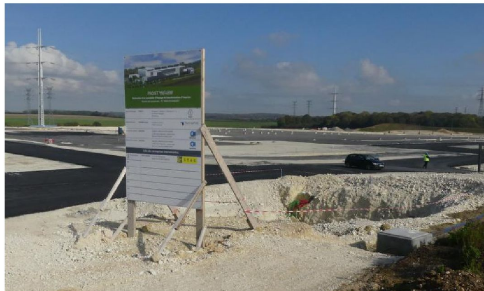
Sur le site de 18 hectares situé au Nord d'Amiens, les travaux avancent à grand pas. L'usine Ynfarm doit ouvrir à la fin de l'année prochaine.
